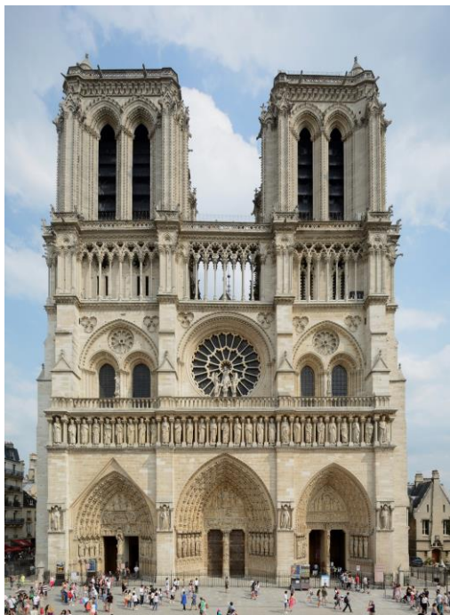
Рис. 4.27. Главный фасад собора Нотр-Дам в Париже, Франция (1163–1350 гг.), современный вид
