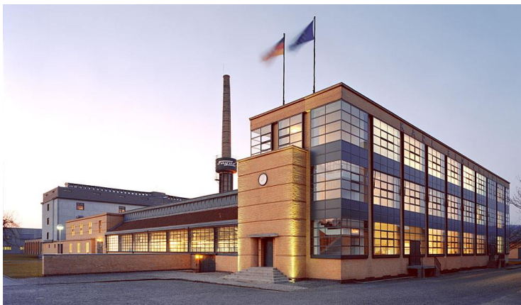
Рис. 4.51. Здание фабрики «Фагус» в г. Альфельд, Германия (В. Гропиус, А. Майер, 1911–1912 гг.)
