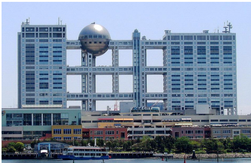
Рис. 4.69. Здание главного офиса телекомпании «Fuji Television» на о. Одайба в Токио, Япония (К. Танге, 1996 г.)
